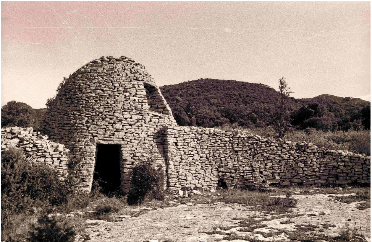
Grange en pierre sèche, aire à battre et rampe d'accès au fenil, Le Beaucet. Photo Pierre Sèche en Vaucluse.
